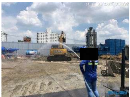
11. ฉีดพรมน้ำลดฝุ่นละออง
