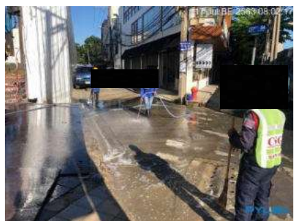
11. ฉีดพรมน้ำลดฝุ่นละออง
